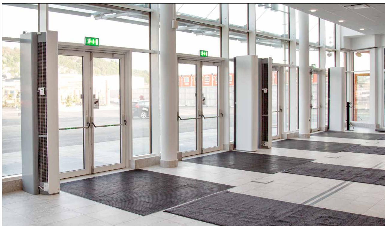
Vertikalt montert Pamir 3500 med en designpakke som brukes for å skjule rør og kabler.
